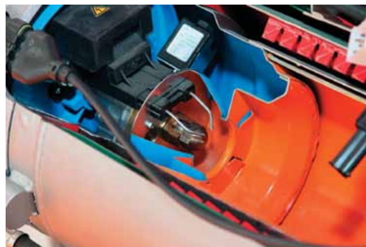
Для замены вышедших из строя элементов котла специальный инструмент как правило не требуется. Ремонтные работы в большинстве случаев производятся при помощи стандартного набора торцовых головок и рожковых ключей.
