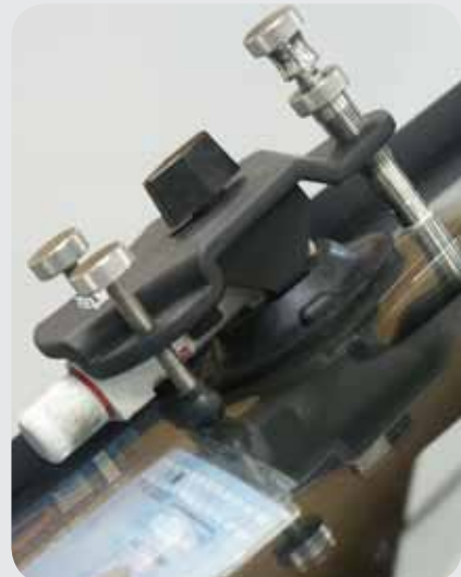
Заполнение полости повреждения специальным составом...
