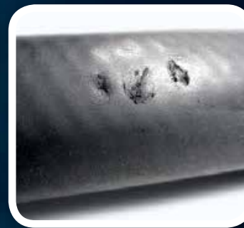
Рис 2. Типичная картина ущерба от прокуса кунницей: небольшие следы от зубов на топливном трубопроводе, ставшие источником засасывания побочного воздуха
